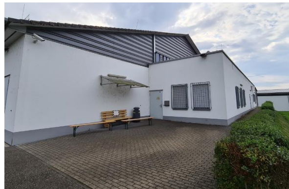
Rückwärtiger Bereich an der Nordseite
