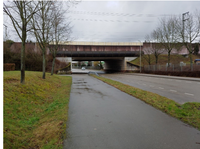
Bild 2: Sander Straße in Richtung Westen
