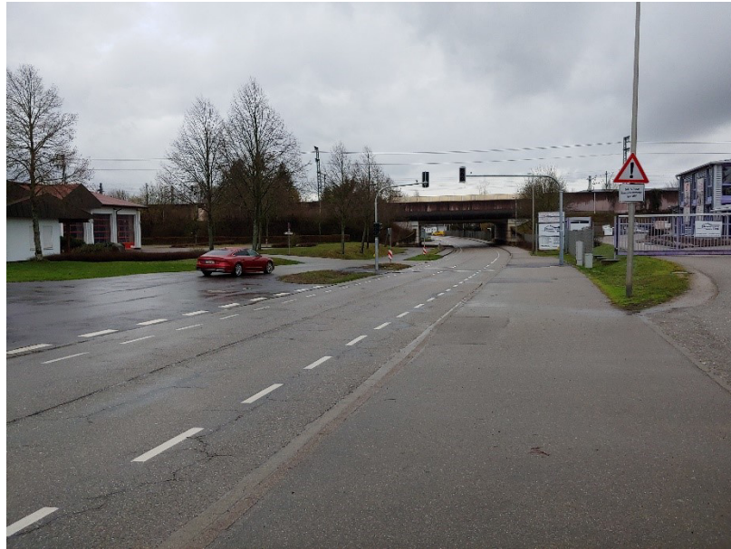
Bild 5: Sander Straße in Richtung Westen
